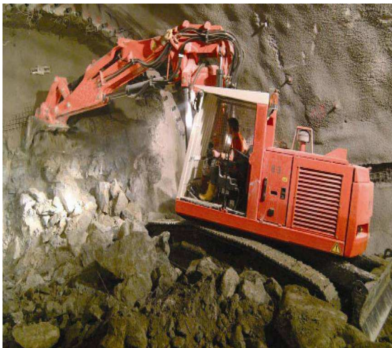
Obrázek 6: Hydraulické rýpadlo při práci na čelbě
